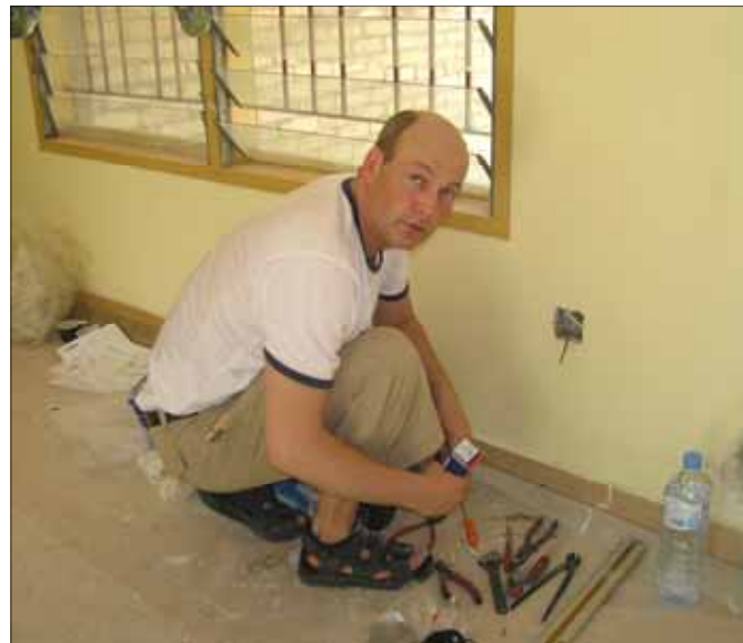
Tormod Bergsland holder på med det elektriske anlegget
