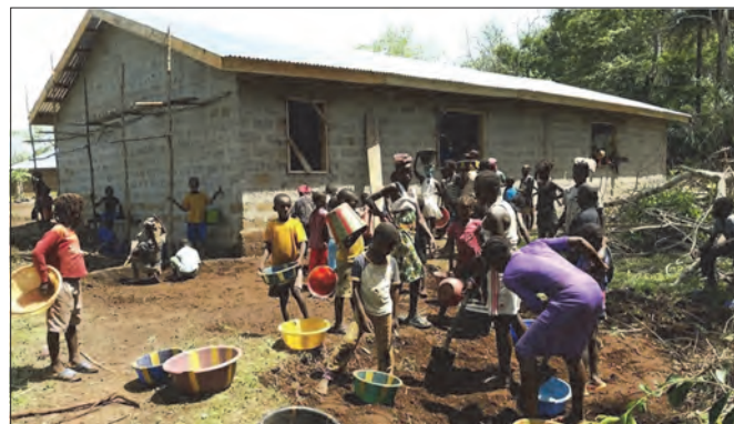
Dugnadsinnsatsen er stor når gulvet skal lages
